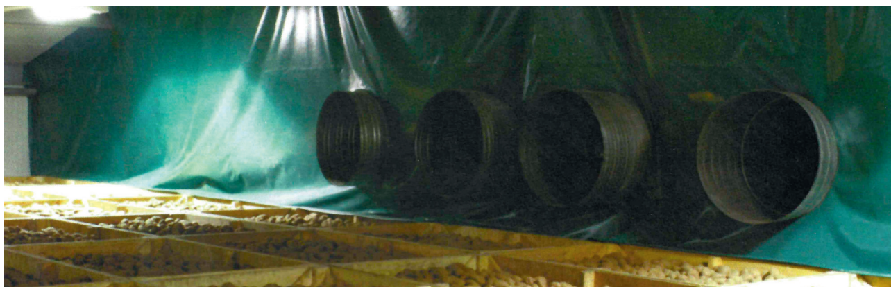
Рис. 3.1 Разделение подаваемого и возвратного воздуха с помощью занавеса
